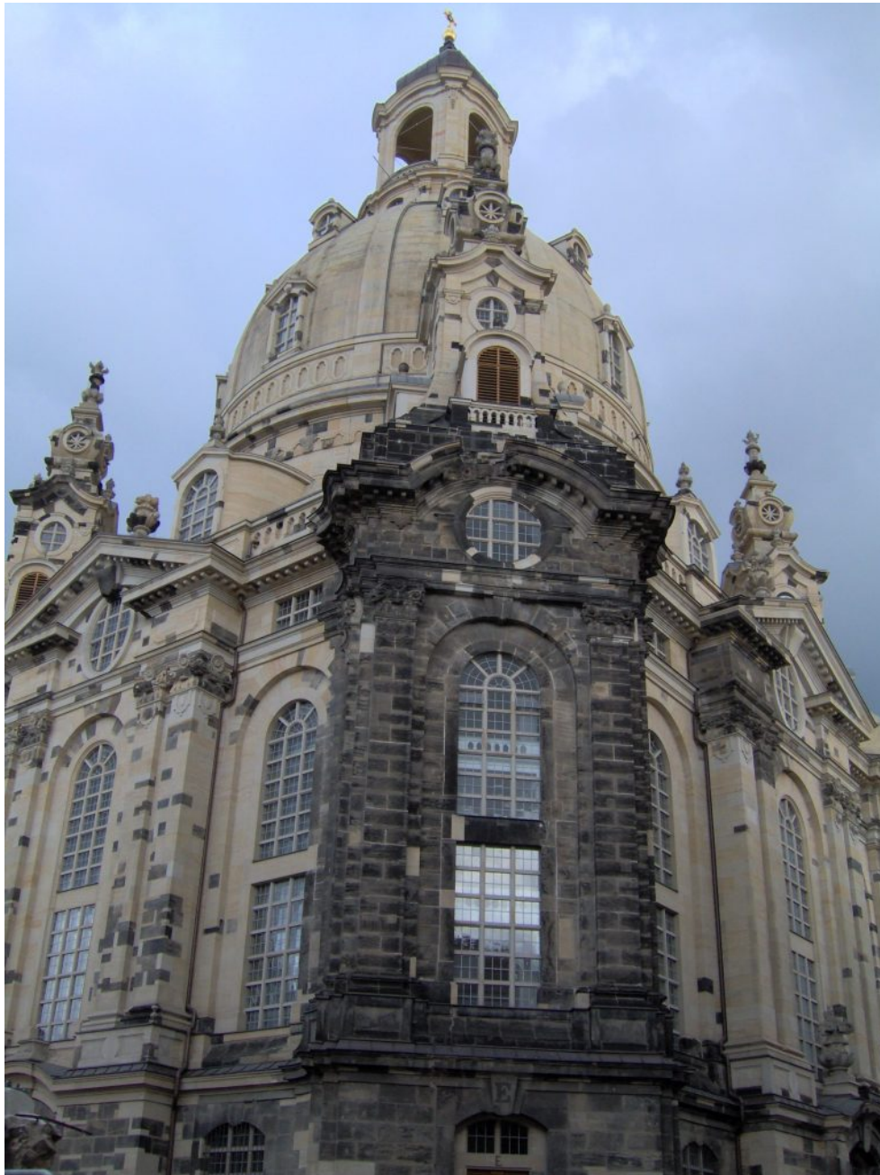
Figure 4. Dresde, Frauenkirche, avant et après restauration (2005). La présence des pierres originales, noircies par l'incendie, permet au bâtiment d'être également, pour les générations à venir, un mémorial de la destruction de la ville en 1945.
